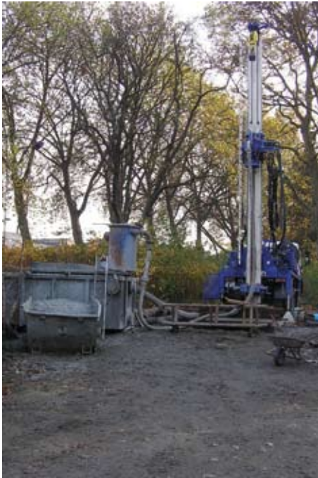
Blick auf die Explorationsbohrung am ehemaligen Bergwerk Dorstfeld in Dortmund: Hier wird Grubengas gefördert: bei Tag und Nacht
