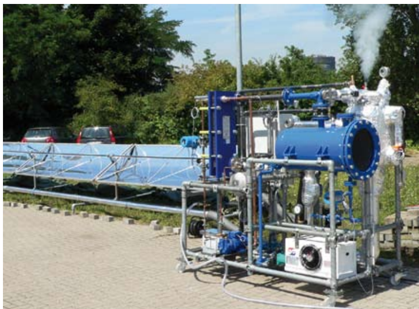
Dampfstrahlkältemaschine (DSKM): interessante Alternative zu konventionellen sorptiven Kälteverfahren
